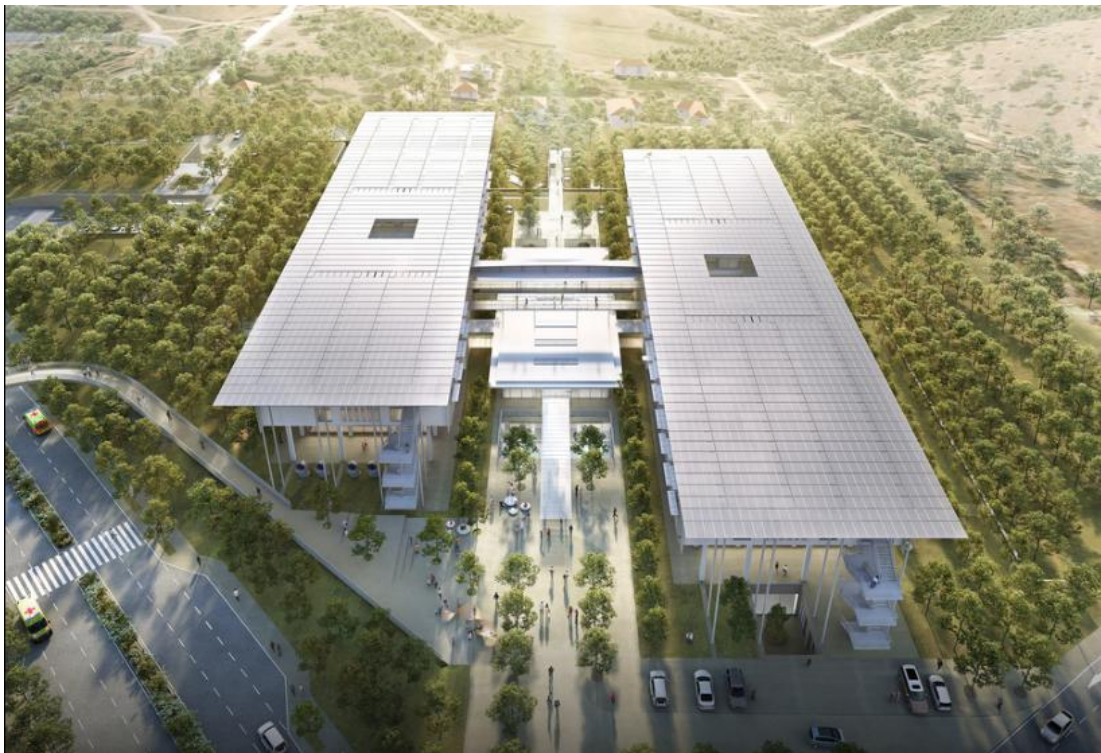
Fig. 14: Cubierta con paneles fotovoltaicos en Hospital de Niños, Tesalónica. Renzo Piano, arq.
